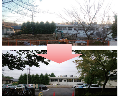
ふれんど平尾プールは、防火用水の機会もなく、ボウフラ発生も危惧され、ここを有効に活用すべく駐車場に用途変更！旧テニスコート駐車場の代替地に。
